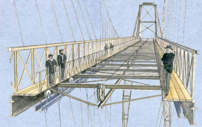
C'est sur le tablier que circule le câble tracteur grâce à un système de poulies. Amarré au chariot, il permet de mettre en mouvement ce cadre rigide circulant sur des rails grâce à 24 paires de galets mécaniques.
